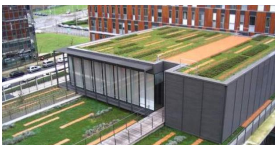
Immeuble du ministère des Finances à Noisy-le-Grand
